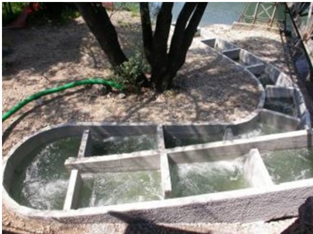
Figura 9: esempi realizzativi di passaggi artificiali per pesci a bacini successivi
