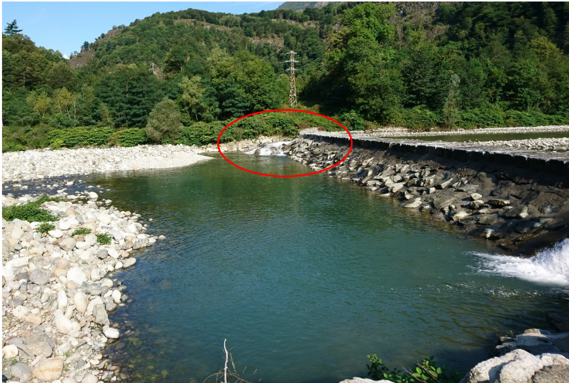
Figura 8: vista dalla traversa da valle, in sponda sinistra, nel cerchio rosso il passaggio per pesci
