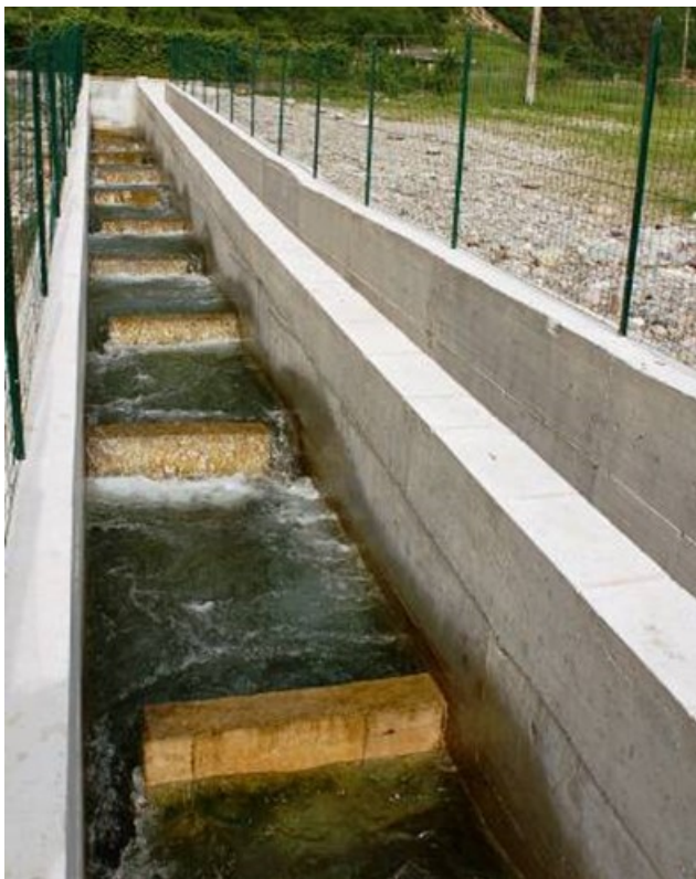
Figura 10: esempi realizzativi di passaggi artificiali per pesci a bacini successivi
