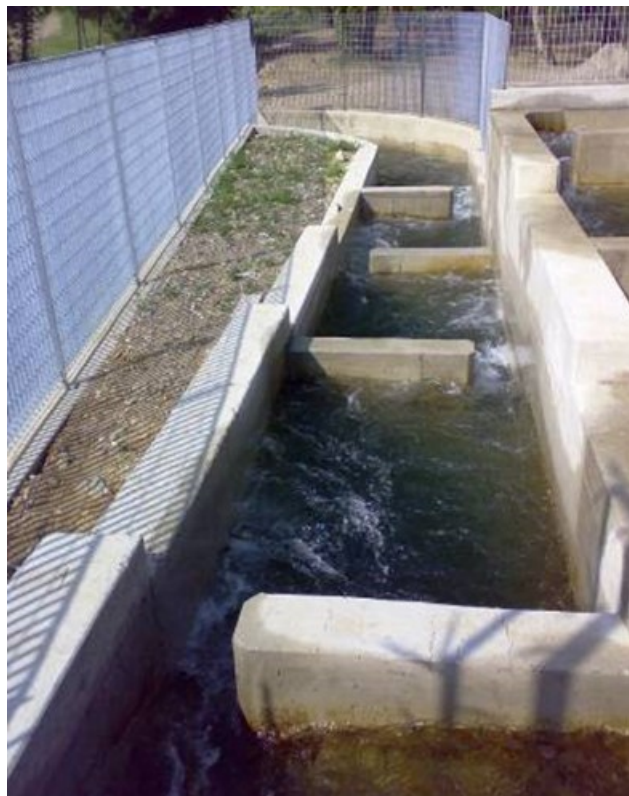
Figura 10: esempi realizzativi di passaggi artificiali per pesci a bacini successivi
