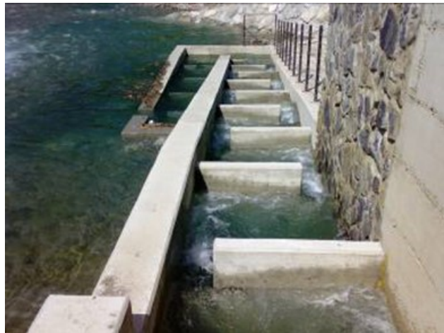
Figura 9: esempi realizzativi di passaggi artificiali per pesci a bacini successivi
